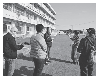
震災遺構 仙台市立荒浜小学校
